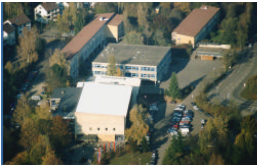
Heidenheim, Westschule, Karl Rau Halle
