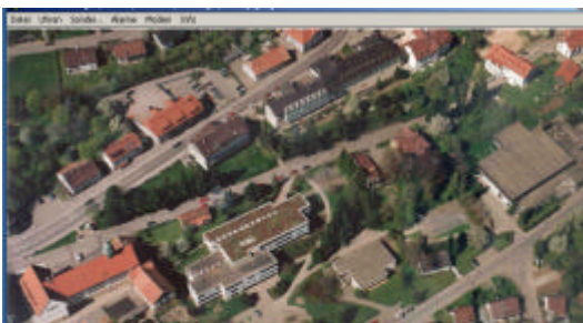
KWA Nahwärmeverbund mit Holzheizung Bonndorf
